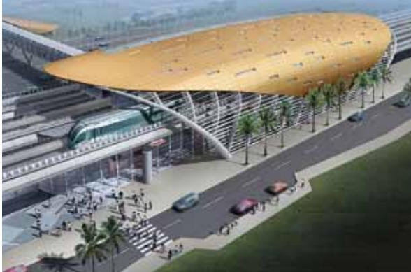
Dubai Metro, Dubai, U.A.E.
